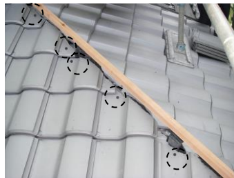
半端瓦を固定します。
